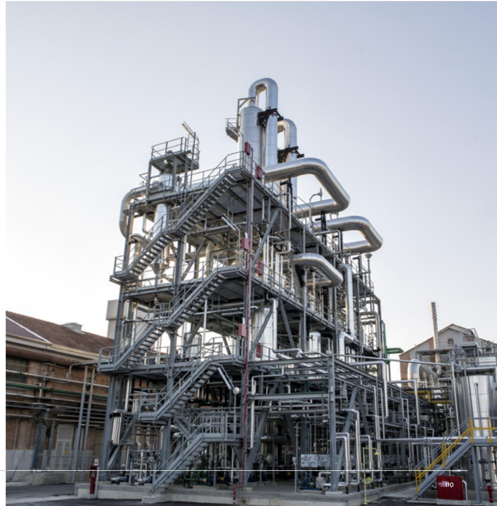
Nello stabilimento di Terni è in funzione un **combustore** impiegato per l'ossidazione termica dei reflui liquidi e gassosi provenienti dal processo di polimerizzazione, altrimenti destinati a impianti esterni di smaltimento. Dal processo di combustione viene recuperata energia termica impiegata nell'attività produttiva e per il riscaldamento degli ambienti. A ottobre 2022, lo stabi-
